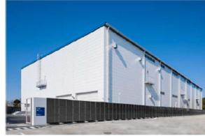
印西精米センターは、国内最大級となる年間生産量70,000トンを実現するだけでなく、機械設備を立体的に配置し、工程間を自由落下で結ぶ事によるお米の搬送設備動力の低減や、最新の機械設備導入による省エネ化により、環境負荷の低減にも配慮した精米工場です。また、当センターでは、無洗米の製造過程で発生する排水を飼料業者に依頼し、飼料原料として再利用する事で、廃棄処理エネルギー及び、CO2の削減に寄与します。加えて、当センターの屋根に太陽光パネルを設置し、発電した電力を供給することで、使用電力の再生可能エネルギー化を推進します。
